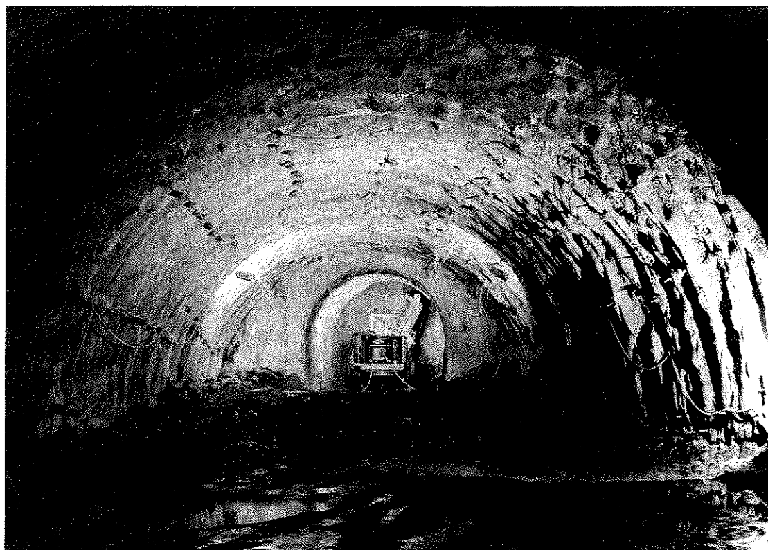
Fig. 3 : Veduta dell'intervento di rinforzo dal cunicolo pilota e della sezione d'allargio.
